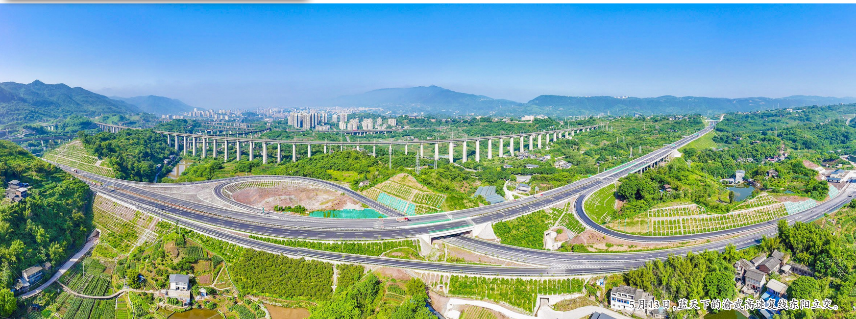
5月14日,在渝武高速复线观音峡嘉陵江大桥上,工人正在进行路面沥青摊铺作业。
