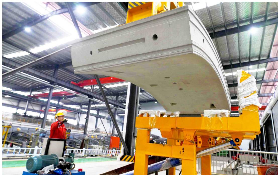
3月24日,在中铁十四局重黔铁路站前2标管片场,工人正在进行管片翻转作业。
