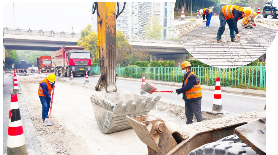
大图 12月24日,在灵犀大道综合整治施工现场,工人们正在对道路进行开挖。 小图 12月24日,在灵犀大道综合整治施工现场,工人们正在对已开挖的道路进行植筋加固。
