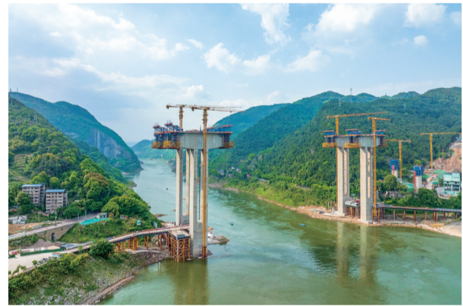
建设中的观音峡嘉陵江特大桥。(资料图)
