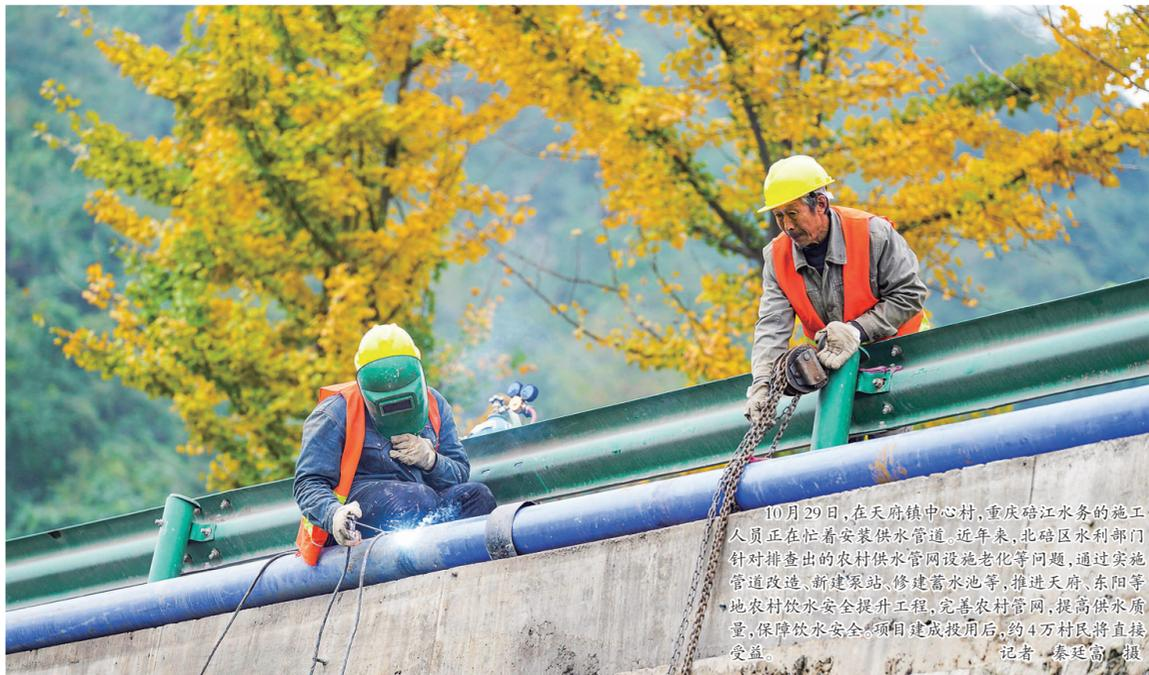
10月29日,在天府镇中心村,重庆碚江水务的施工人员正在忙着安装供水管道。近年来,北碚区水利部门针对排查出的农村供水管网设施老化等问题,通过实施管道改造、新建泵站、修建蓄水池等,推进天府、东阳等地农村饮水安全提升工程,完善农村管网,提高供水质量,保障饮水安全。项目建成投用后,约4万村民将直接受益。 记者 秦廷富 摄
