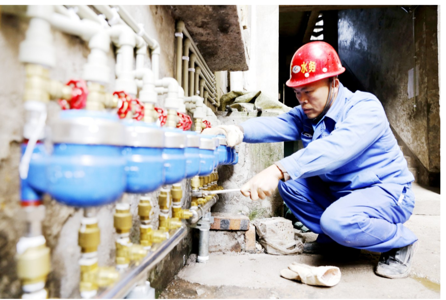
1月8日,在东阳街道七一新村25号,水务公司工作人员在安装调试水表。
