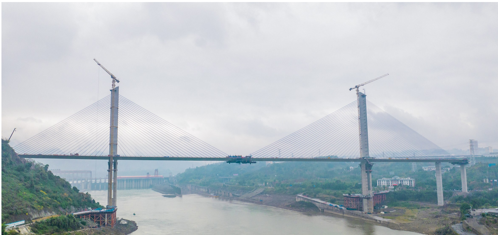
11月30日，渝武高速公路复线草街嘉陵江特大桥合龙。 记者 秦廷富 摄
