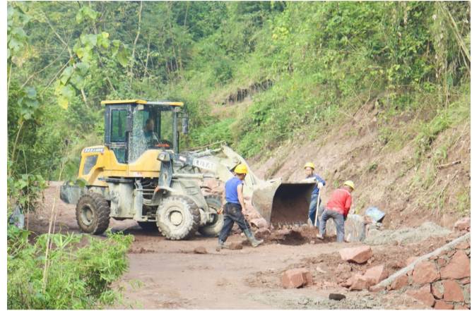
静观镇天星村田家湾路建设现场。实习记者 王欣怡 摄
