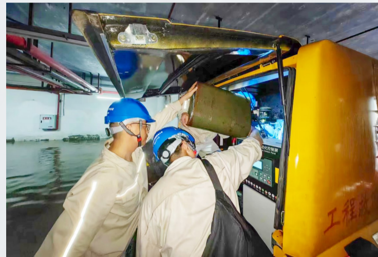
7月2日,国网重庆北碚供电公司工作人员正在抢修电力设施。
