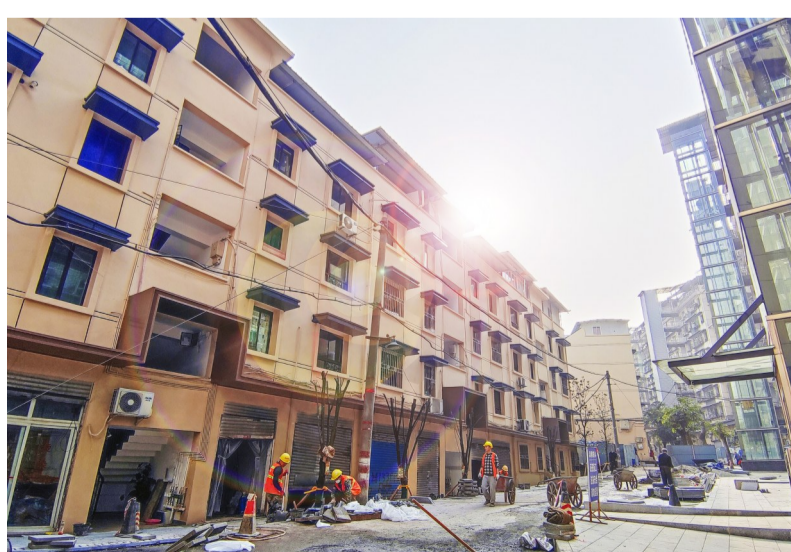
团山堡片区老旧小区改造施工现场。
