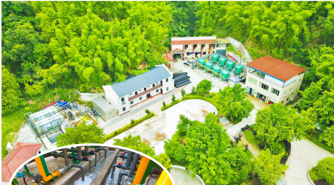
建成投用的江东水厂应急补水工程。
