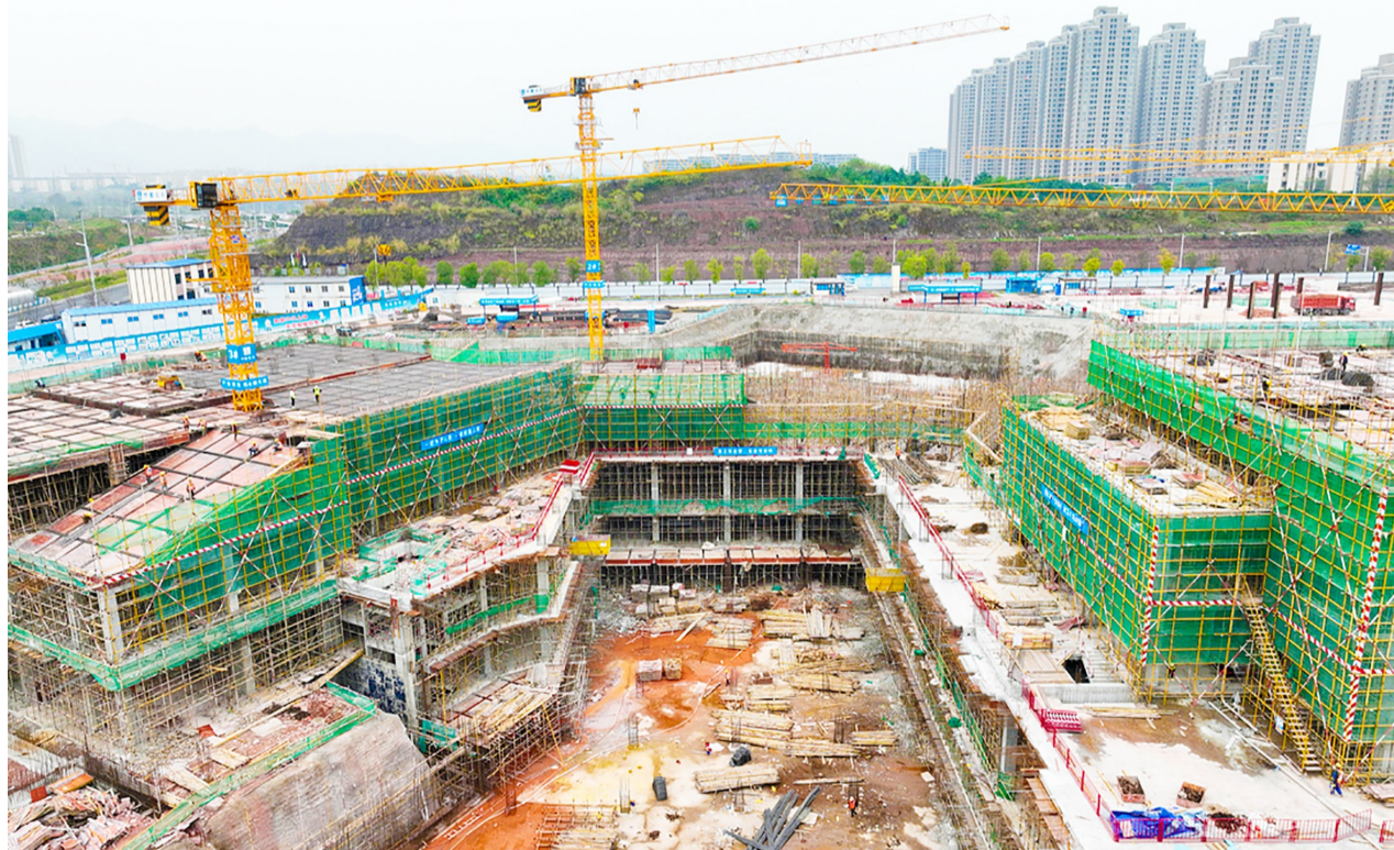
重庆市第九人民医院两江分院建设现场。 记者 秦廷富 摄
