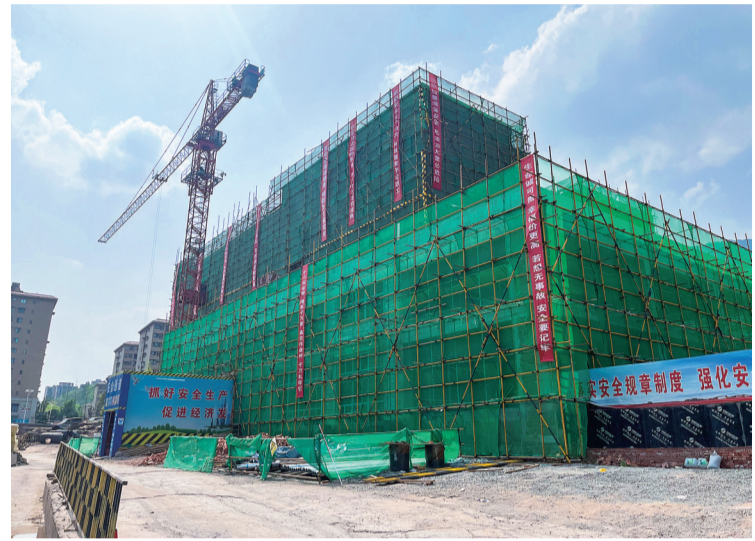
区妇幼保健院主体工程完工,6月建成投用。(资料图)
