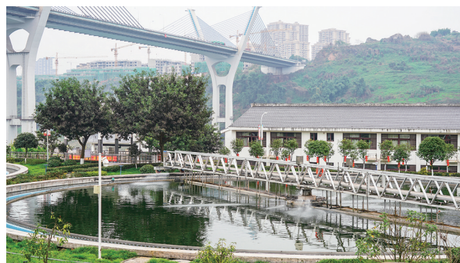
蔡家污水处理厂二期扩建工程完工。记者 彭浩杰 摄
