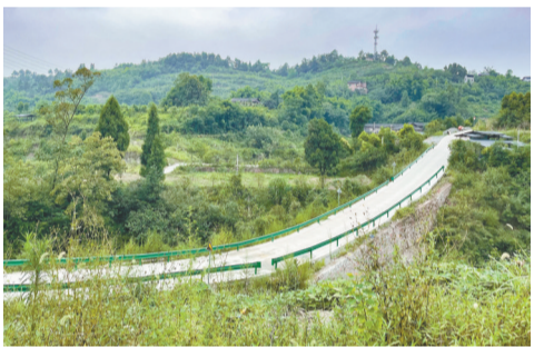
复兴街道农村“四好”公路——太坡路段。
