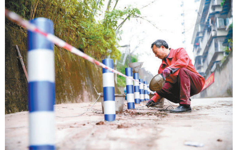
在天生街道龙溪路社区七一新村,工作人员为消防通道安装隔离桩。
