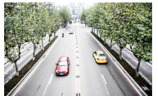
改造完工后的碚峡路焕然一新。
