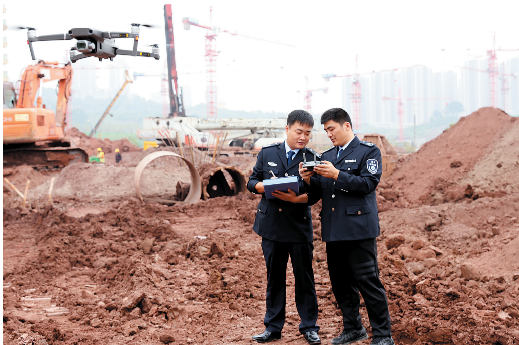
执法人员使用无人机对施工现场进行扬尘监测。
