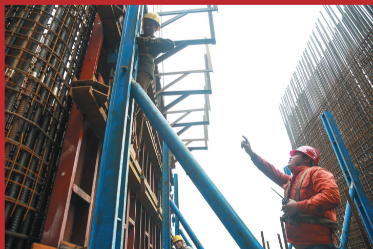
牟江勇指挥工友安装桥墩模板。
