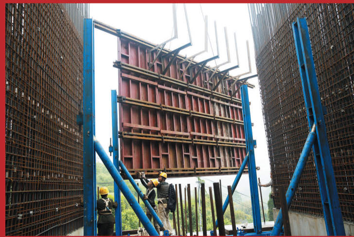
工友们在安装桥墩模板。
