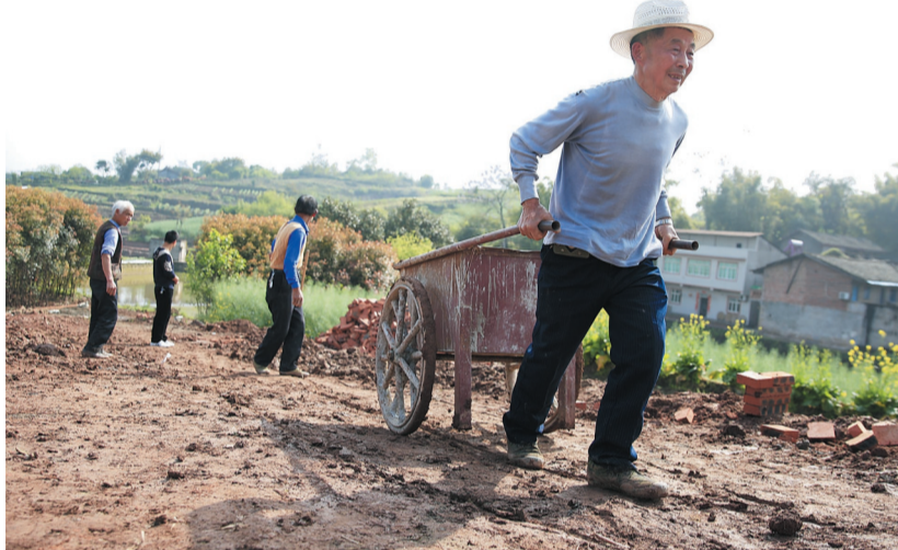
3月29日,静观镇吉安村邹家沟组村民正在修建“致富路”。
